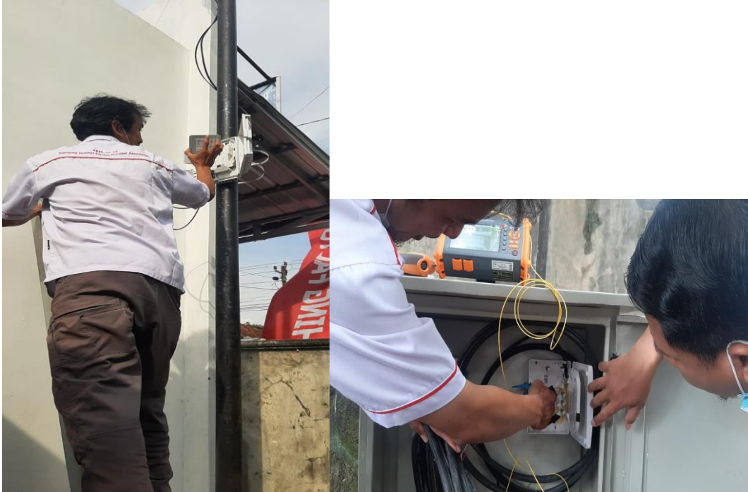
Gambar 6. Guru menunjukkan cara memasang dan cara kerja Optical Distribution Point (ODP) pada tiang telepon.
