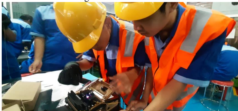
Gambar 5 Siswa melakukan proses penyambungan kabel fiber optik
