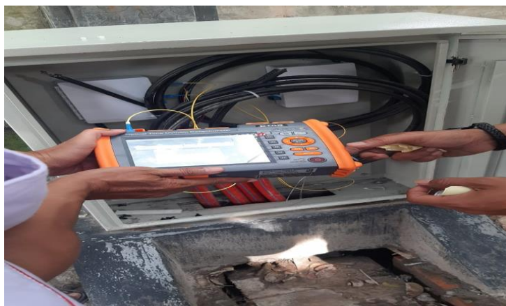
Gambar 5. Melakukan pengecekan kualitas dan menganalisa sinyal fiber optik dengan OTDR
