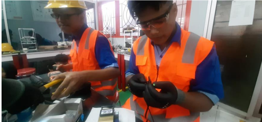
Gambar 5. Siswa melakukan proses penyambungan kabel fiber optik secara manual menggunakan fast conector
