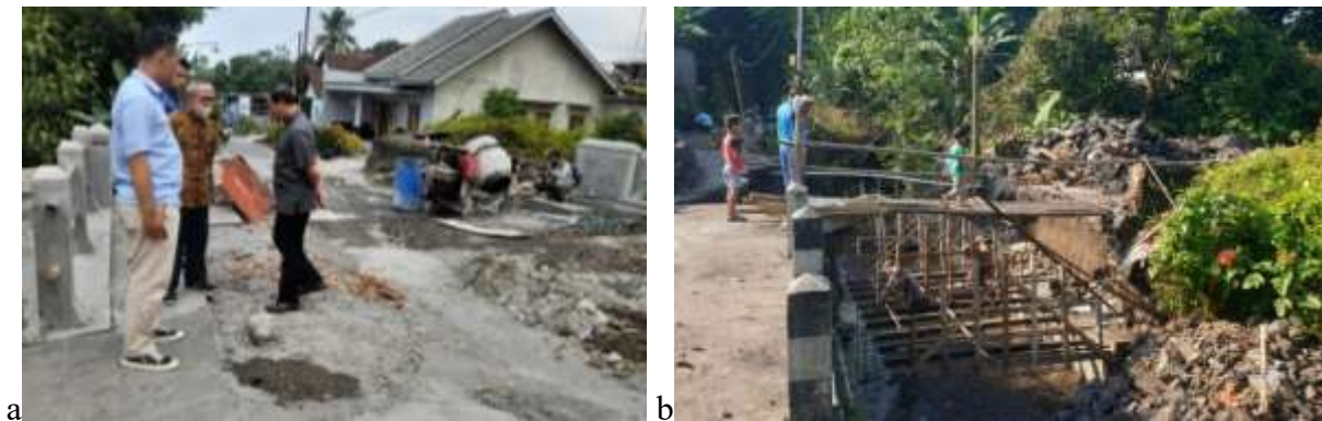
Gambar 5. (a) Tim Abdimas meninjau lokasi dan (b) pembongkaran jembatan lama
