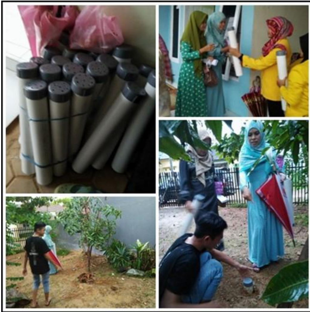
Gambar 3. Tahapan kegiatan terakhir setelah pemberian materi di rumah warga setempat. Searah jarum jam: (a) Sejumlah pipa paralon sepanjang \pm 40 cm yang dilengkapi dop berlubang; (b) Pembagian pipa paralon yang berfungsi sebagai lubang resapan biopori oleh panitia kepada peserta kegiatan; (c) Contoh praktek langsung pembuatan lubang resapan biopori oleh peserta kegiatan; dan (d) Arahan dan penjelasan model lubang resapan biopori oleh mahasiswa kepada peserta kegiatan
