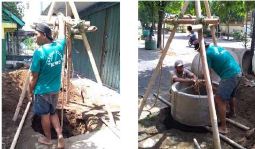
Gambar 6. Pengerjaan sumur resapan
